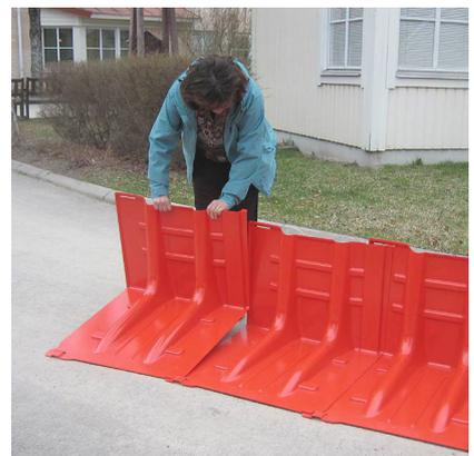
Une barrière Boxwall se construit en fixant à tour de rôle les boîtes l'une dans l'autre. Le montage s'effectue facilement en partant de la gauche vers la droite (vu du côté « sec »). Il faut éviter de construire la barrière en partant de deux points différents car il est difficile de faire se rencontrer les deux parties de la barrière exactement au même point.
